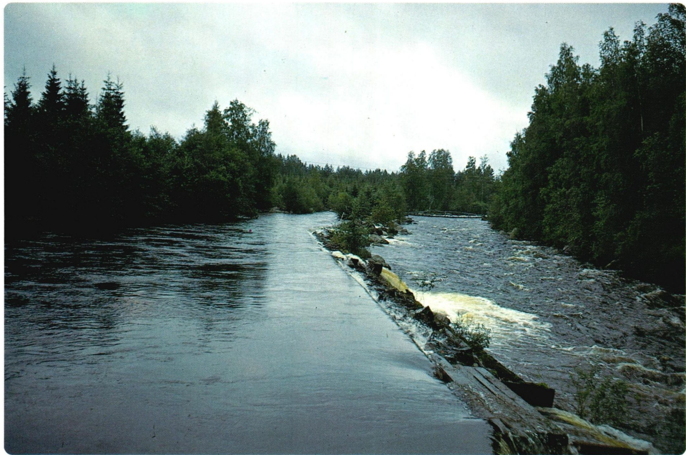
Från Välisuvanto och ned till landsvägsbron delas forsens av en stenlista, i en huvudfåra och en kanal till kraftverket. I bakgrunden skimtar bron över Välisuvanto, en omtyckt fiskeplats. (Foto Otto Nettelbladt).
