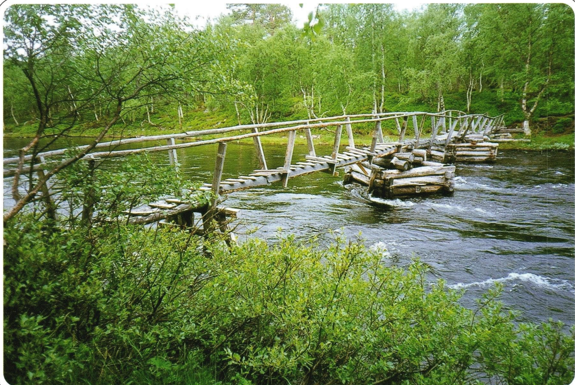
Gångbron över Röa vid Rösanden.
