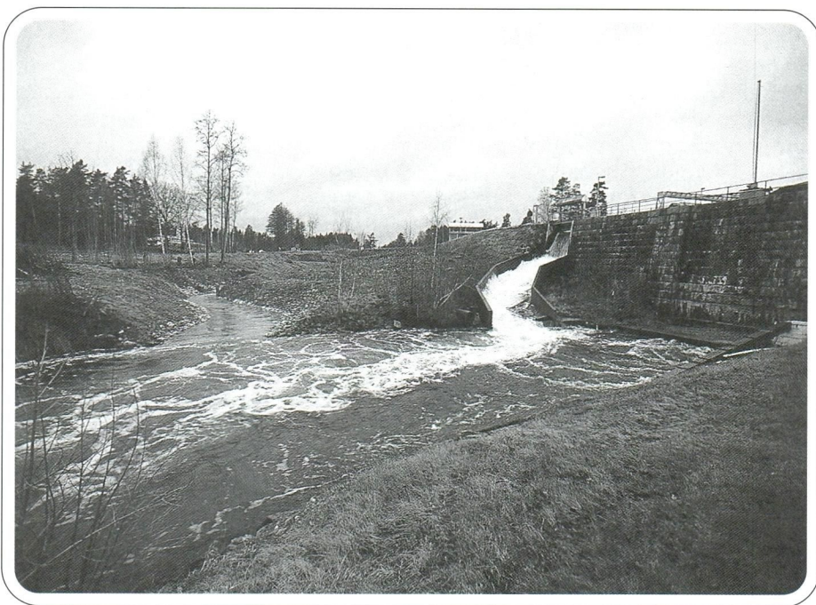
Det nya omlöpet vid Finsjö nedre.
